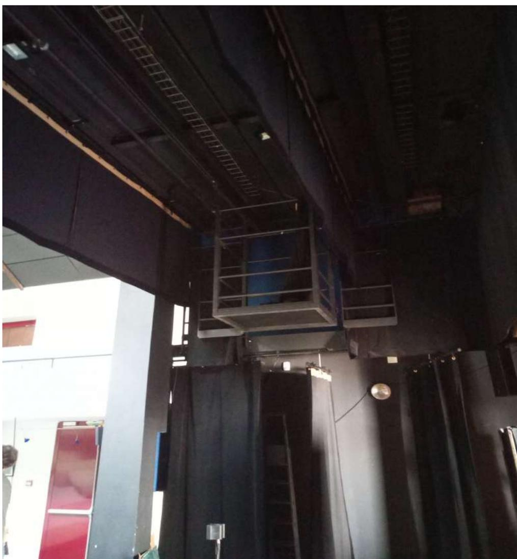
Passerelle de face à 3,60m du proscénium et 5m de hauteur.
